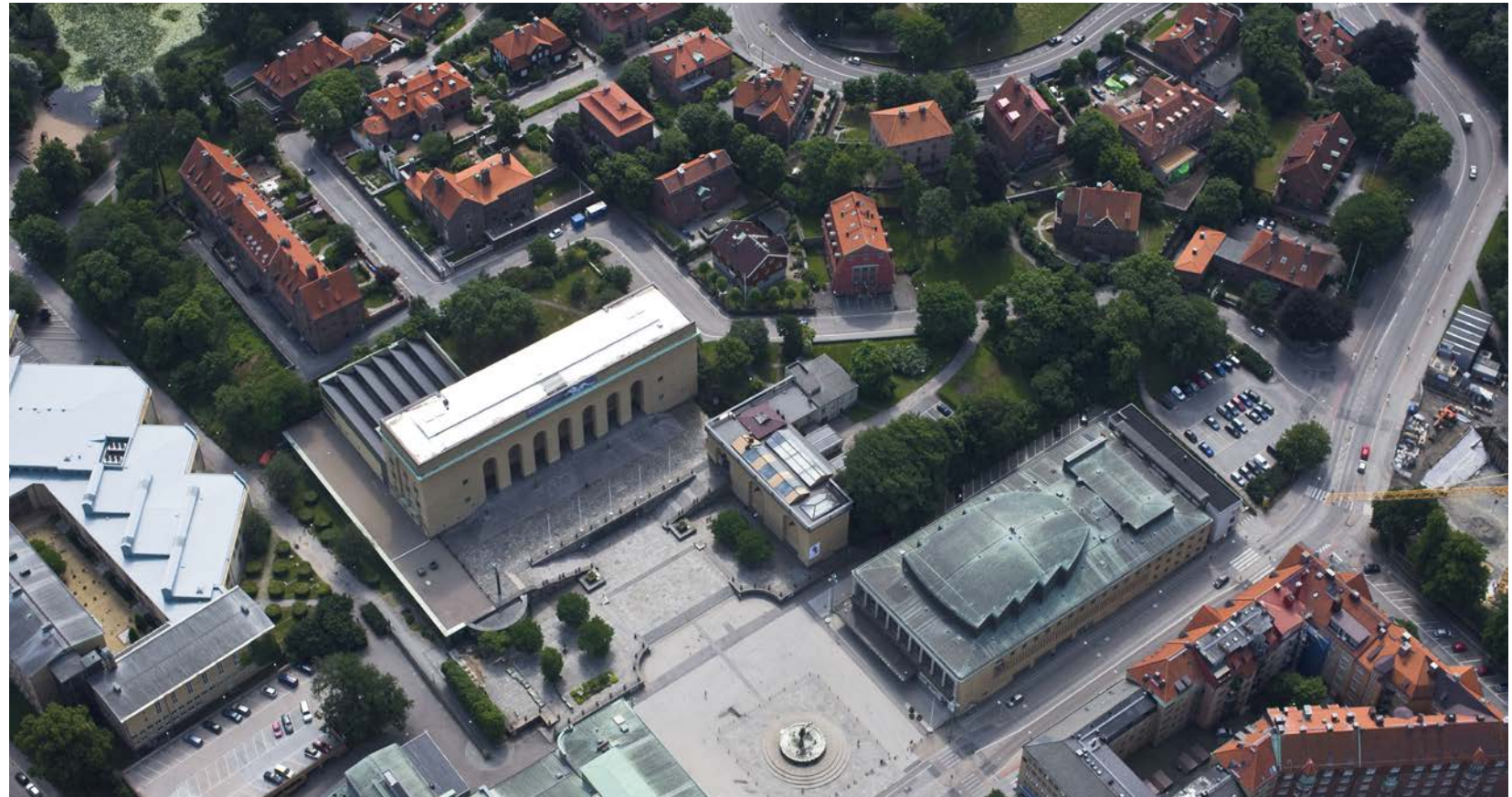
GÖTEBORGS KONSTMUSEUM FRÅN OVAN. STADSBYGGNADSKONTORET, BYGGNADSNÄMNDENS ARKIV.
